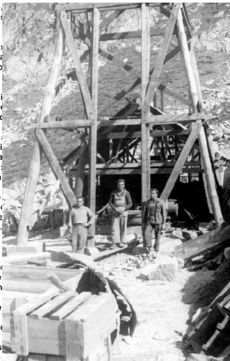
Montaje de la Pilona del Boulu, también hecha por Pueyo y Manota.
