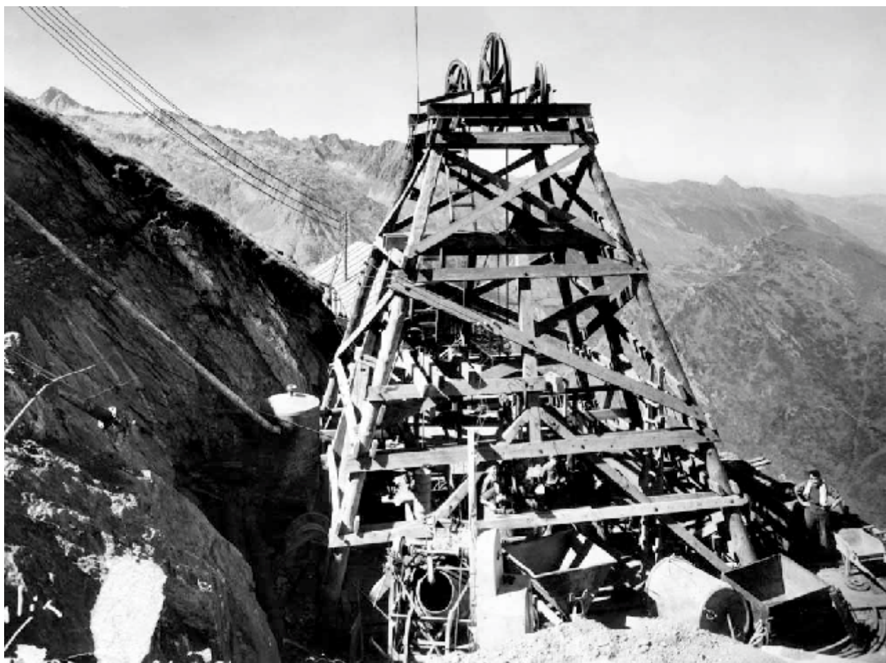
Torre (Pilona en francés) de mis trabajos en la montaña.
